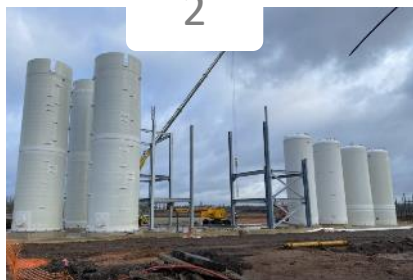
Janvier 2020 Installation des cuves intermédiaires
